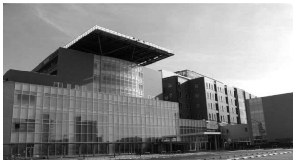
写真① 海南病院の外観
