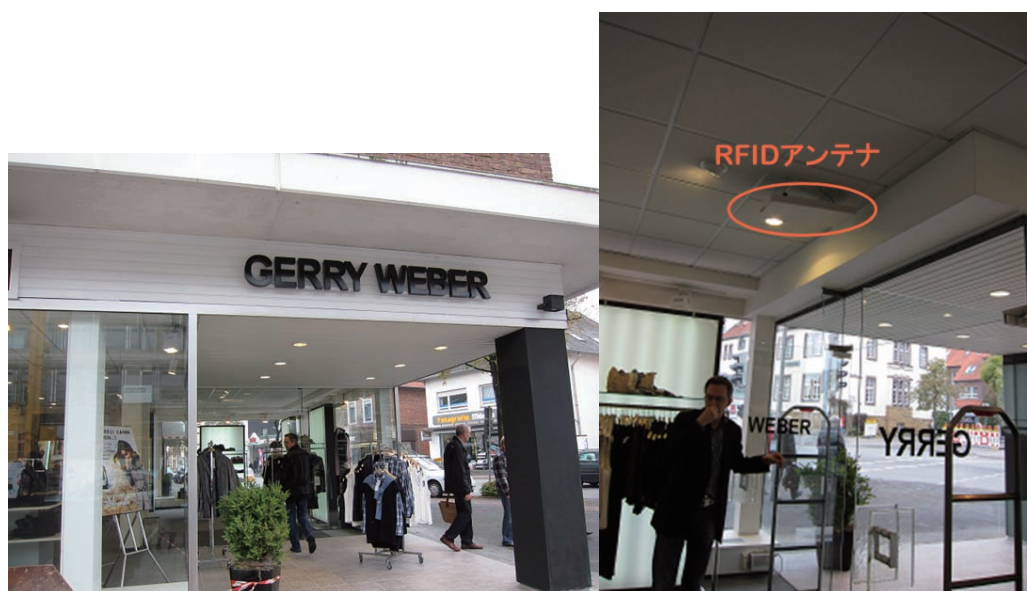
(左) 本社近くの直営店外観 (右) 天井に設置された EAS 用 RFID アンテナ
